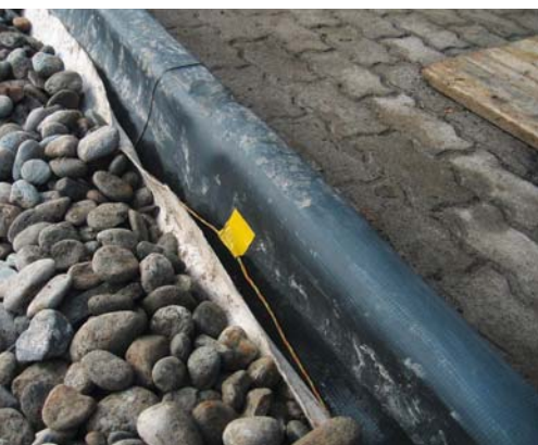
Um Lecks im Teich zu suchen, ist eine Ringleitung mit Weidezaunlitzen nötig. Diese kann bereits beim Bau installiert werden.
